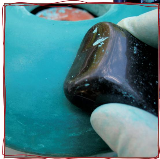
Das Aufbringen von Seifenlösung lässt eine wasserfeste Kalkseife in der Tadelaktschicht entstehen. Das Wasser perlt dann auf der Oberfläche ab.
